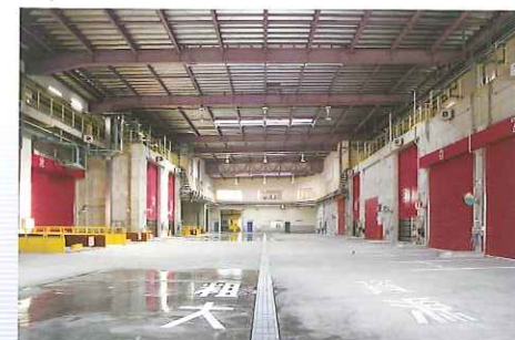
1 プラットホーム リサイクルプラザに持ち込まれた粗大ごみ、資源化ごみの受入を行います。
