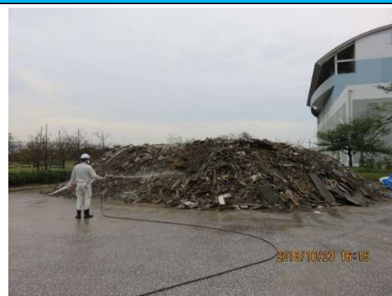
スレート散水作業
