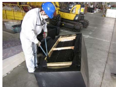
写真14 スプリング除去
