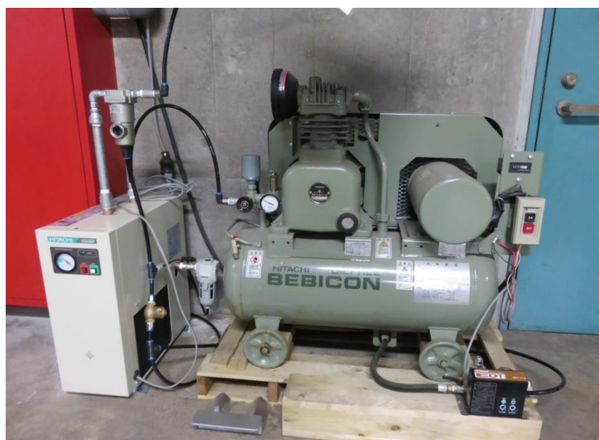
写真 1 除湿器とエアフィルター設置
